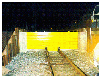
図 5．止水壁設置状況
