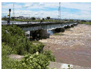
図 10. 那珂川増水状況
