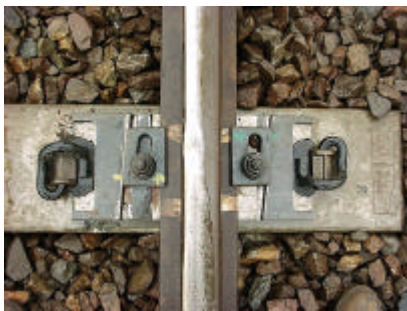
図 - 6 : 基準線用タイププレート
