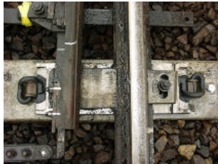
図 - 4 : 締結装置(スライド床板)
