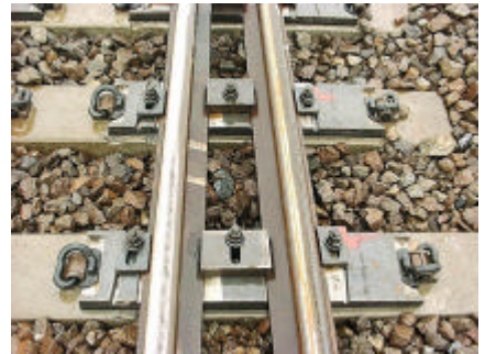
図 - 5 : 締結装置(ヒール固定端)
