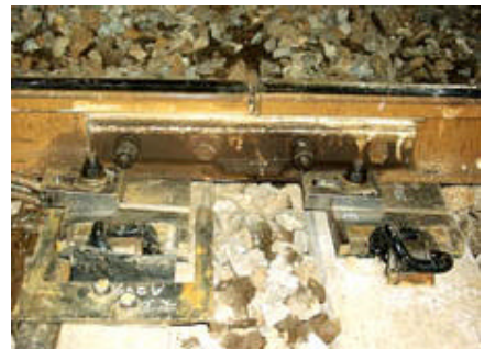
図 - 8 : 前端継目用タイププレート
