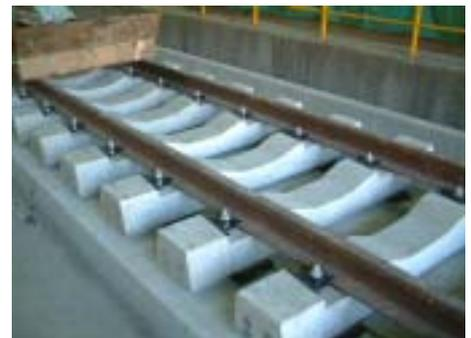
図2 まくらぎ直結バラスト軌道（バラスト散布前）
