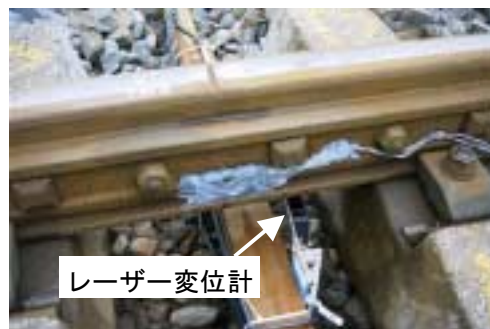
図 1 レール上下変位の測定状況
