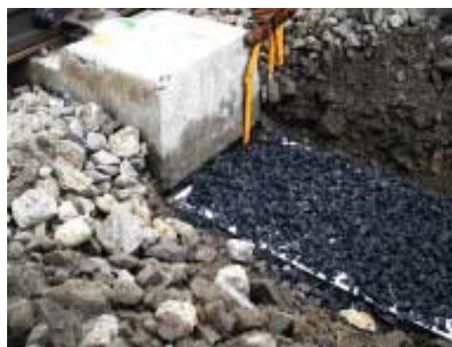
図 3. ゴムチップ敷込み工法
