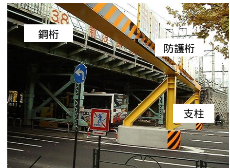
写真-1 橋桁防護工
