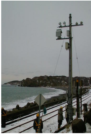
図-4 現地監視カメラ
