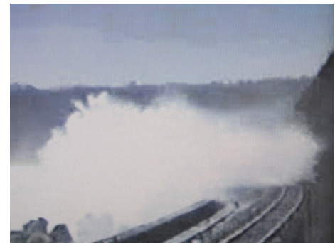
図-2 越波発生状況
