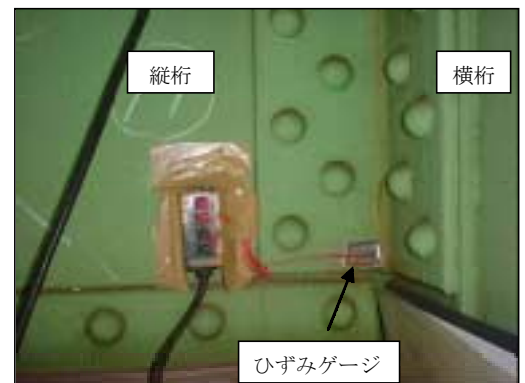
写真-1 ひずみゲージ貼付の一例
