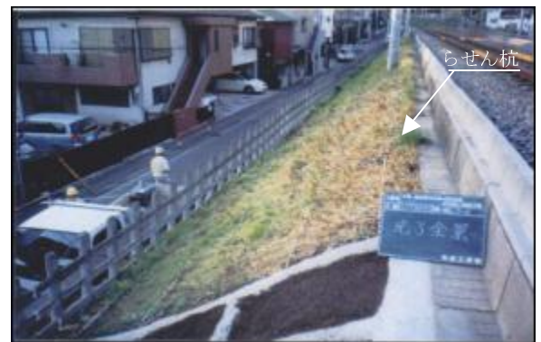
写真1 試験施工完了後の状況
