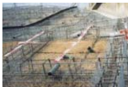
写真-1 水抜孔の増設
