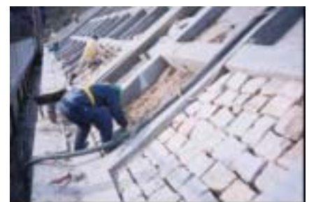
写真-2 岩座張り
