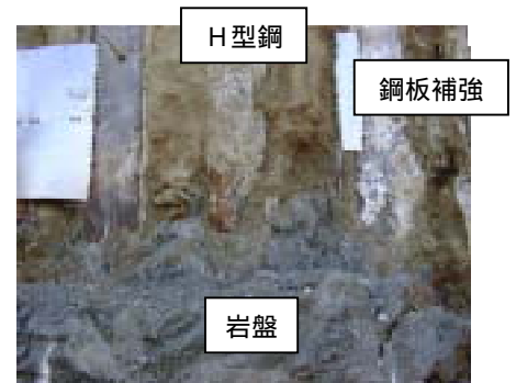
写真-1 吸出し防止対策
