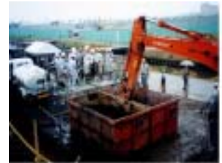
写真－2 攪拌混合状況
