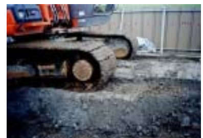
写真－5 転圧状況
