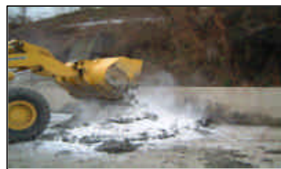
写真3. 重機攪拌状況
