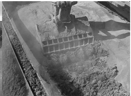
写真-3. PS 灰による改質状況
