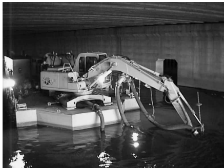
写真-1. 真空ポンプ船による浚渫作業
