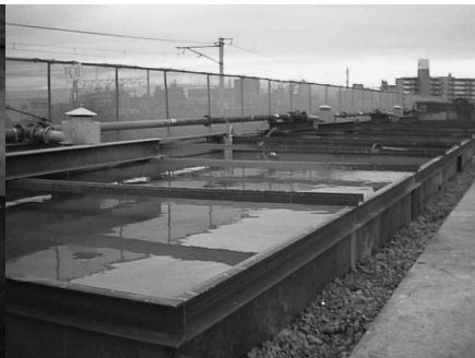
写真-2. 改質ピット
