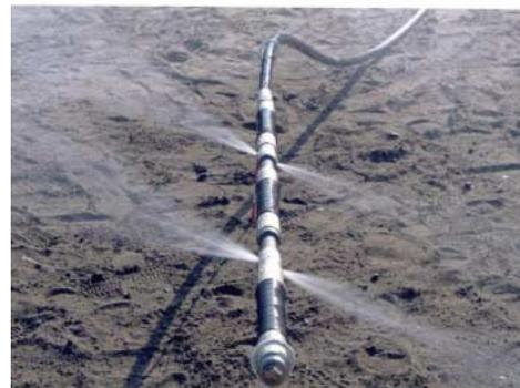
写真-2 マルチパッカを有する注入内管からの多段同時噴射状況
