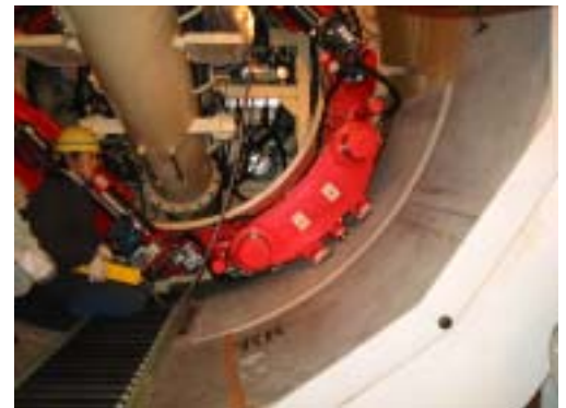
図 - 6 組立試験状況
