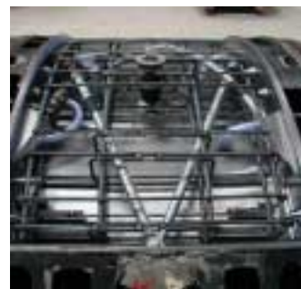
写真-1 配筋状況
