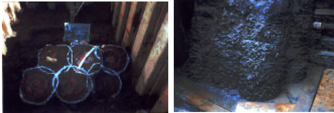
写真1 改良体造成状況（左：上部 右：側部）
