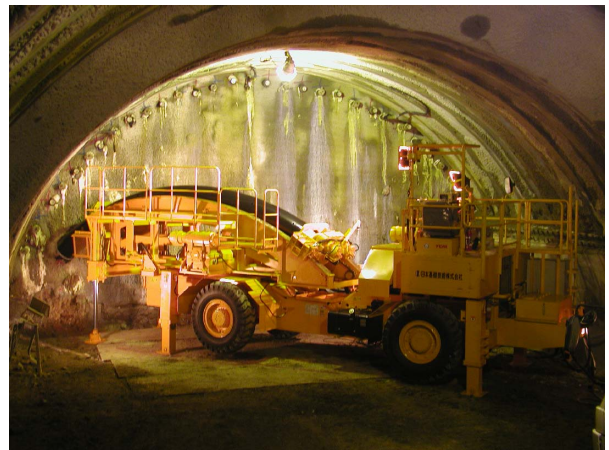
写真 - 1 トンネル坑内における施工性の確認
