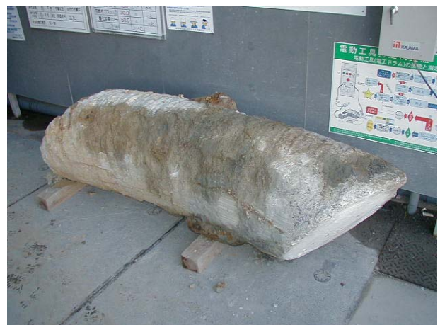
写真 - 3 改良体確認
