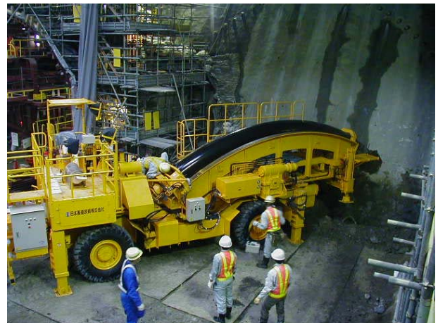
写真 - 2 削孔性能の確認
