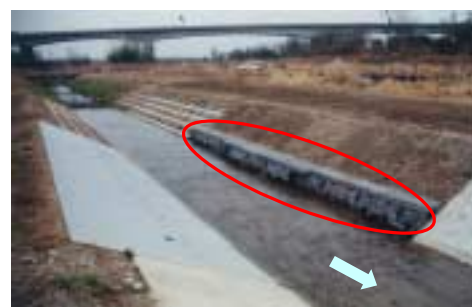
写真-1 護岸区間全景
