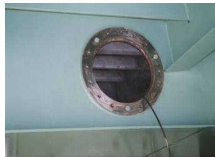
写真4 マンホールの状況
