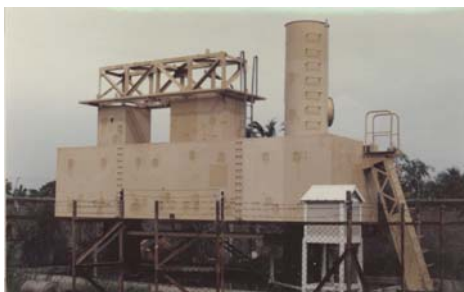
写真1 試験塔の外観
