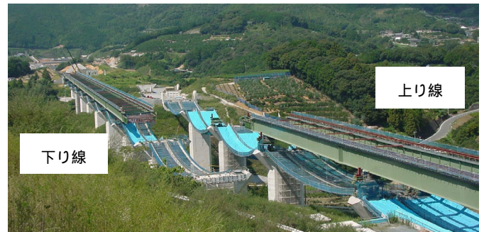
写真-1 送り出し架設状況
