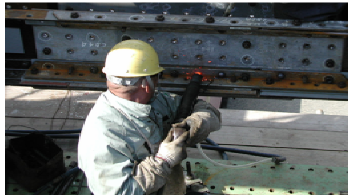
写真-2 リベット施工状況
