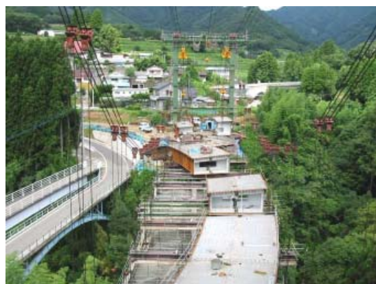
写真-1 架設状況
