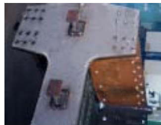
写真-1 横桁上の柔ジベル
