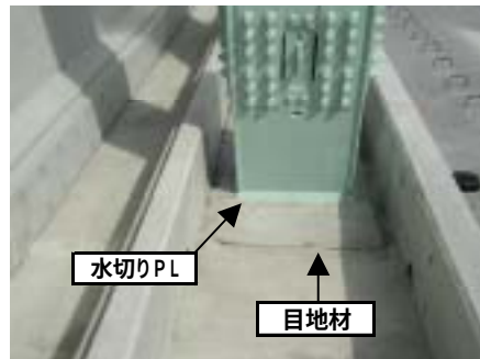
写真-4 格点部の構造
