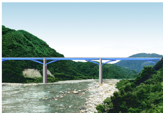
図－1 弾性支持連続桁橋
