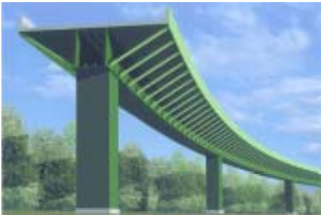
図-1 ストラット付鋼単箱桁橋の全景
