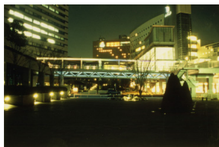
写真8 計画デッキ完成後
