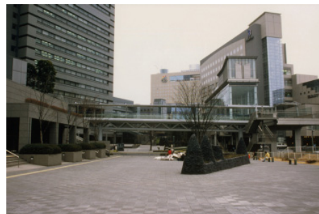
写真4 計画デッキ完成後
