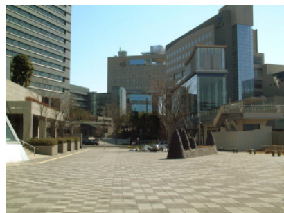
写真2 計画デッキ完成前
