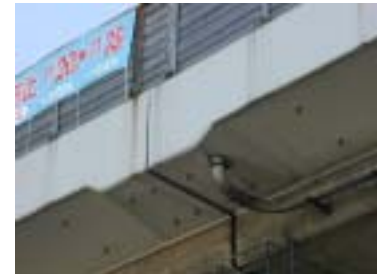
写真-1 中央ヒンジ部高欄上部
