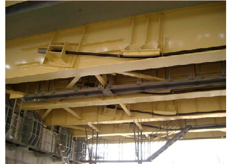
写真1 外ケーブル補強した鋼鉄桁
