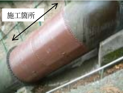
写真－2 施工完了後の状況
