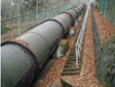
写真－1 試験施工現場
