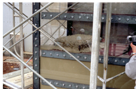
写真－2 打設状況（縦方向の流れ）
