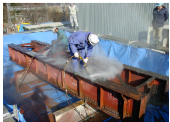
写真2 塗膜はく離作業状況
