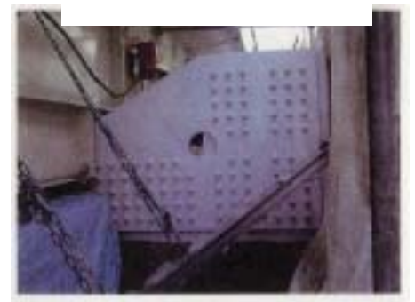
写真-2 当板補強
