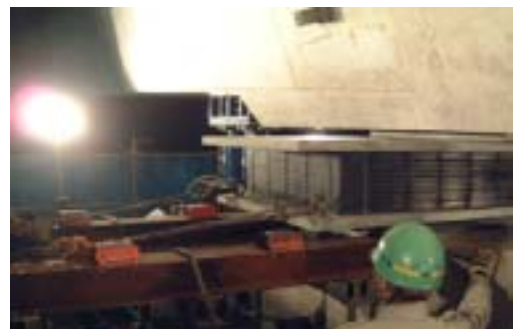
写真-3 回収支承引出し
