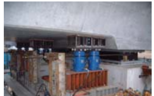
写真-2 ジャッキアップ
