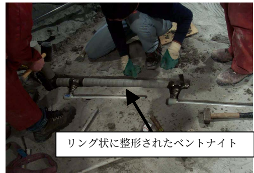
図-3 ステンレス鋼管周辺の止水対策 (リング状に整形されたベントナイトの設置状況)
