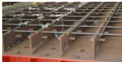
BPL床版は、補強用のBPLを底鋼板に溶接し、BPLとコンクリートとを機械的に結合するスタッドを溶接し、上部に鉄筋を配置してコンクリートを打設する合成床版である。この構造は、BPLと底鋼板で囲まれるコンクリート部分がBPLの球部とスタッドによる拘束を受けて、鋼との合成効果を発揮させようとするものであるが、底鋼板とのずれによる合成効果の低下の評価及び拘束と付着をとり入れた設計手法の開発が必要である。ここではBPL床版の静的載荷試験を実施し、合成床版としての機能を発揮することを確認したので、報告する。
