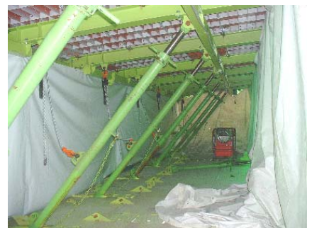
写真－4 防風シート
