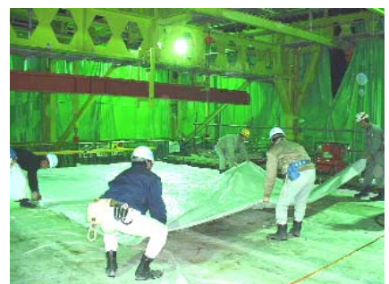
写真-2 シート敷設
