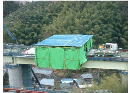
写真－3 屋根と防風カーテン
