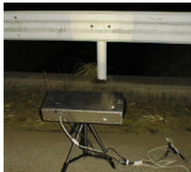
図-3 橋梁防護柵計測状況
