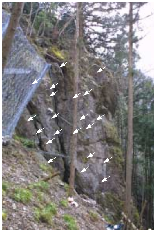
図-3 岩盤斜面におけるデジタル写真計測。矢印の先端にターゲットが配置されている。写真中央に左上から右下に見える直線が同時に行っている光ファイバ計測。
