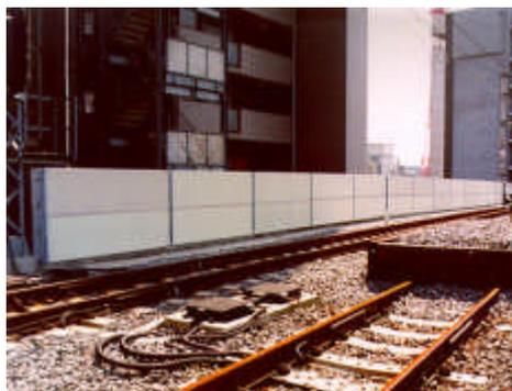
写真-2 鉄道高架橋高欄吸音パネル
