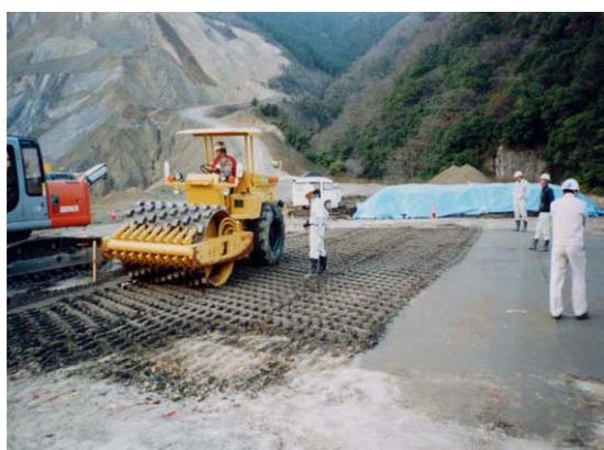
写真-4 タンピング振動ローラーによる転圧
