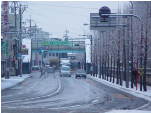
写真 - 4 降雪センサーによる間欠運転区間の状況
