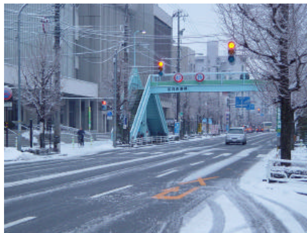
写真-2 非散水区間（散水区間の直隣）の状況
