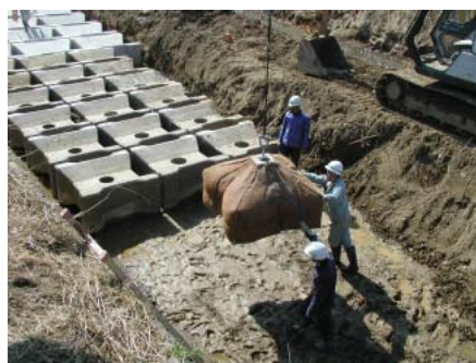
写真-3 設置状況
