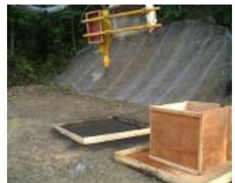
写真 - 2 吐出量・圧密試験状況
