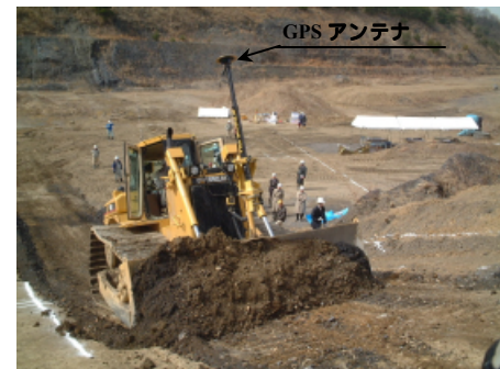
写真-2 3D-MC(ブルドーザ)による作業状況
