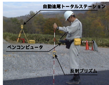
写真-1 3D-NAViによる測定状況
