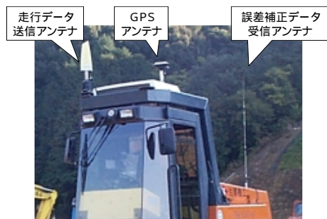
写真 - 1 アンテナの取付
