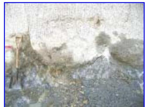
図-8 地下連続壁の先端露出状況
