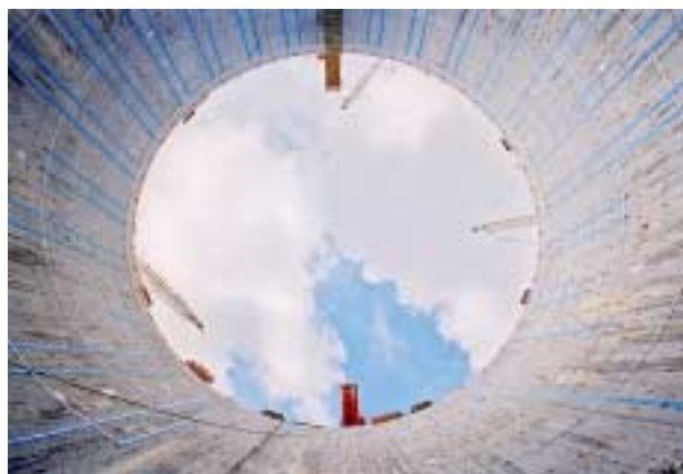
写真-1 連壁面の状況
