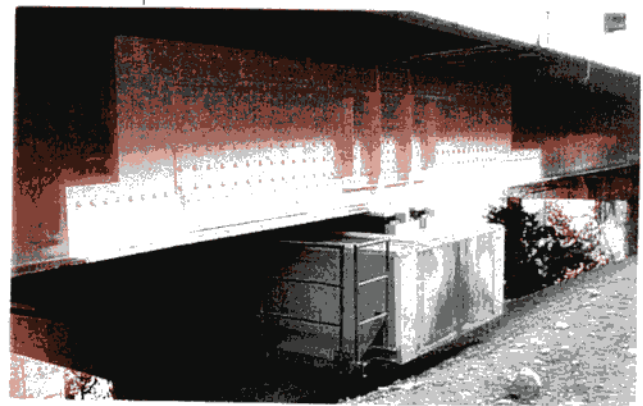
写真-1 桁連結状況
